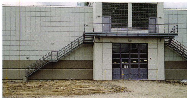
Värmepumpenläggning i Hammarby, Stockholm
