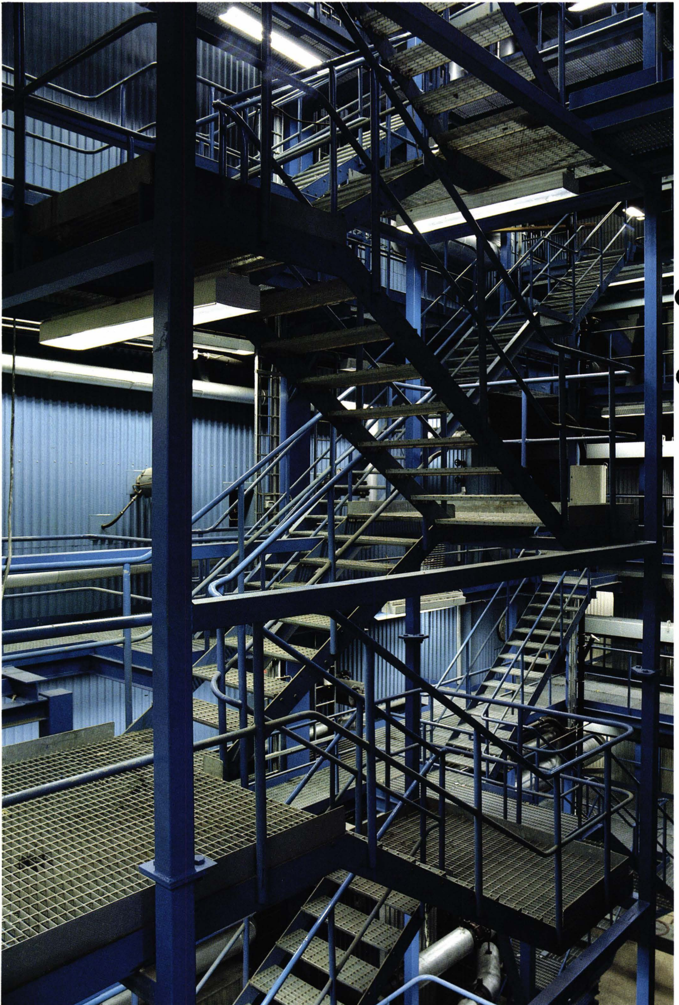
Igelstaverket i Södertälje, Pannhuset.
