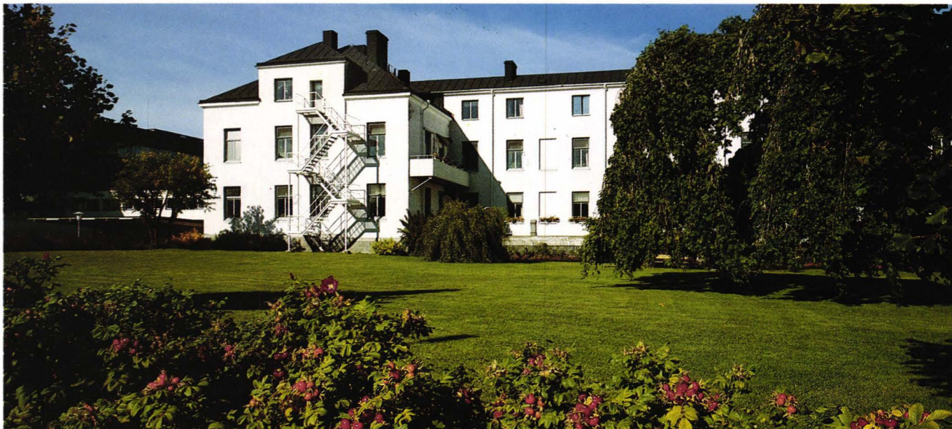
Sjukhus i Norrköping, Utrymningstrappa.
